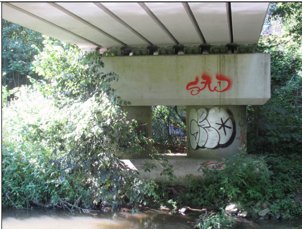
Obr. č. 16 – pohled na pilíř (č.1) tvořený dvěma sloupy a stativem
