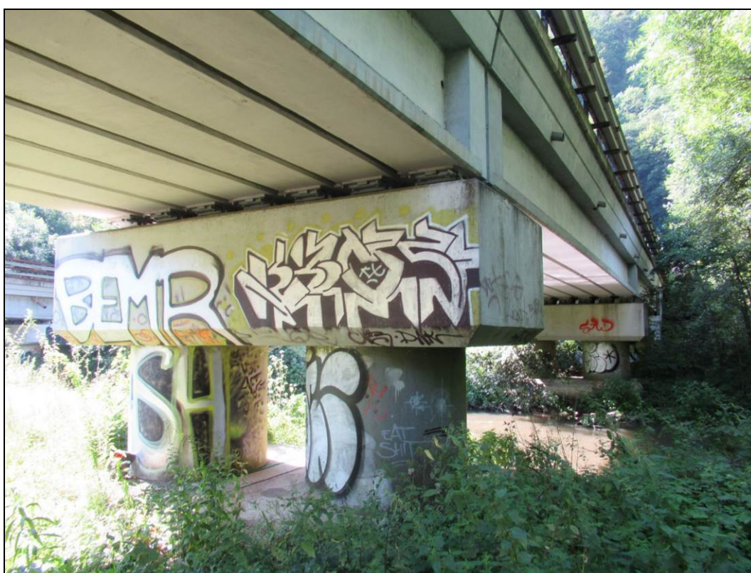
Obr. č. 15 – pohled na pilíř (č.2) tvořený dvěma sloupy a stativem
