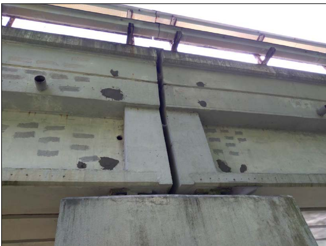
Obr. č. 19 - detailní pohled zleva na úložný práh pilíře 2 a ukončení NK nosníků a nasazené desky 2. (vpravo) a 3. pole (vlevo)
