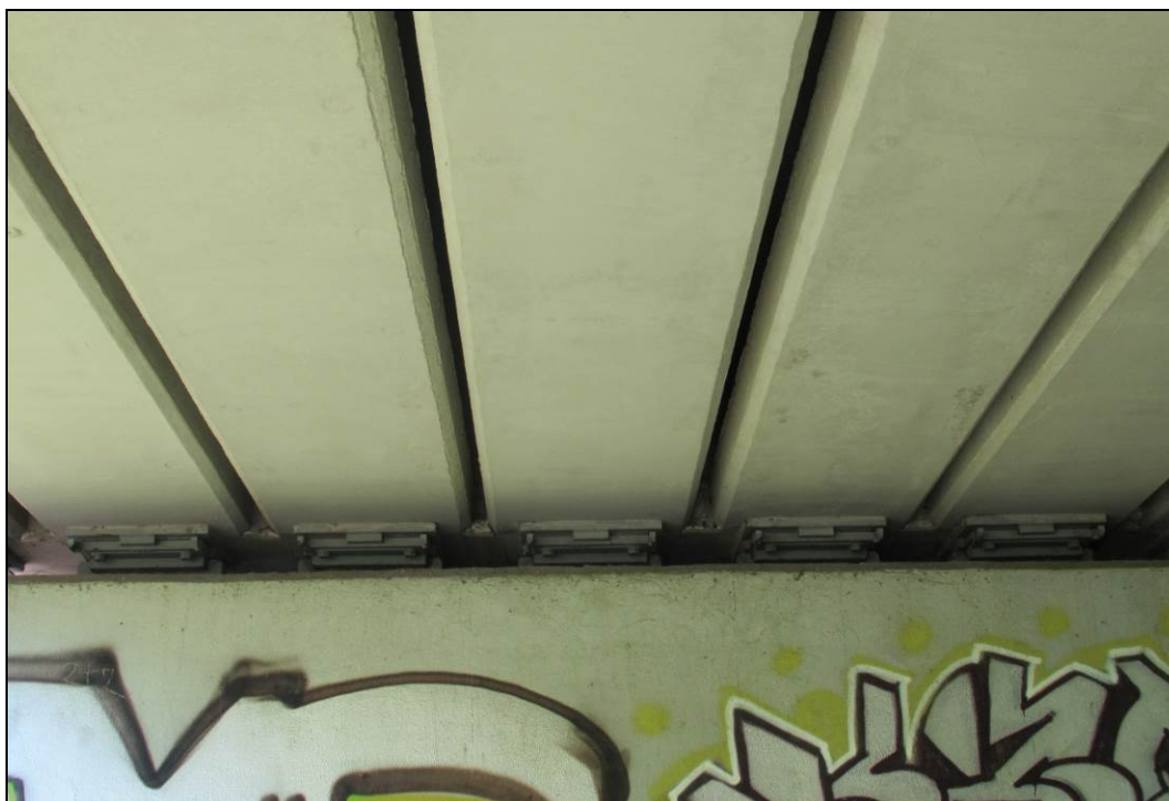
Obr. č. 17 – pohled na spodní líc nosníků a jejich uložení pomocí ložisek na stativu
