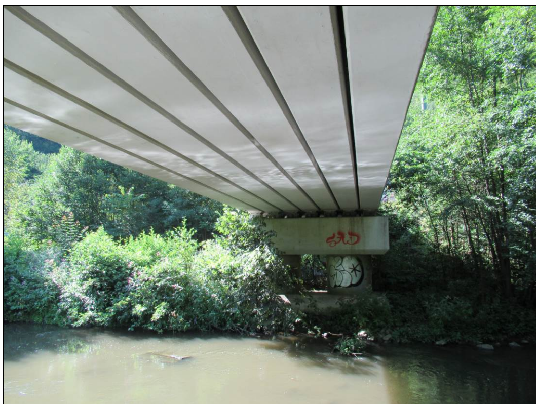
Obr. č. 18 - pohled na pevný a hladký spodní líc nosníků
